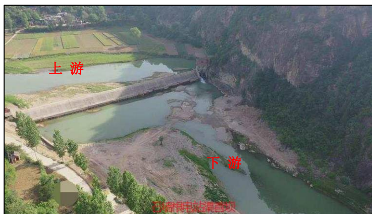
石墙根水电站渠首坝上下游
