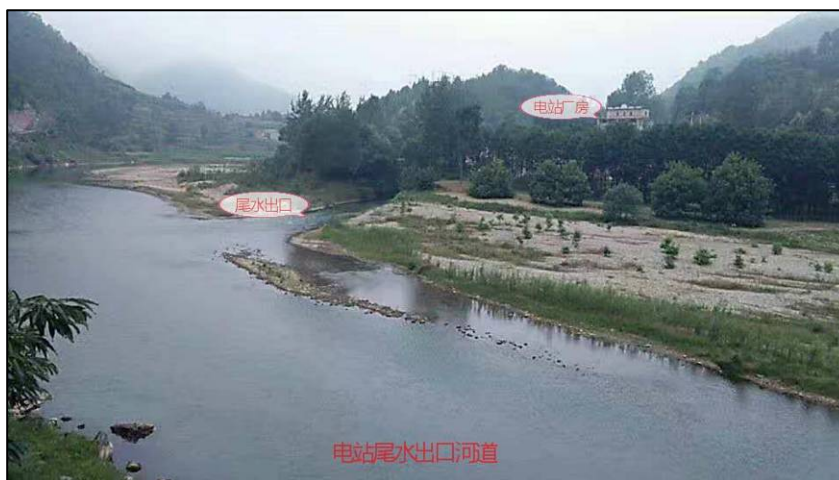
电站尾水出水口河道
