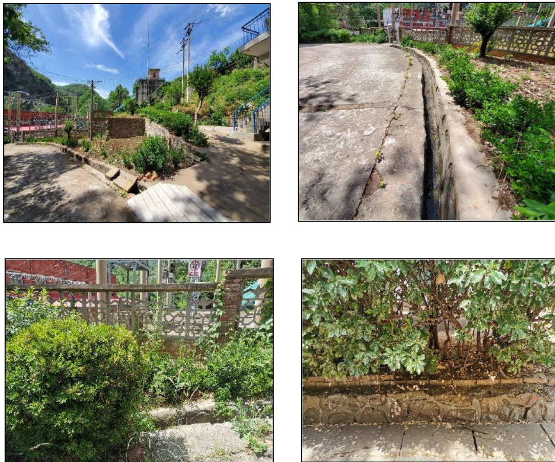
电站排水沟现场照片
